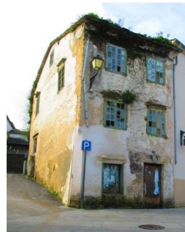
Inmable necesitado de rehabilitación na área Rexurbe de Mondoñedo
