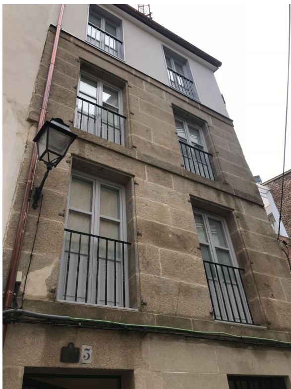
Fachada de Vilar 1
