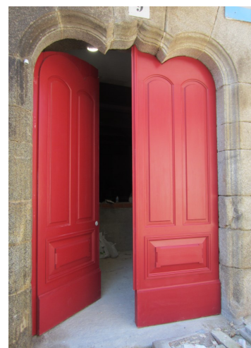
Porta rehabilitada de Cerca 9
